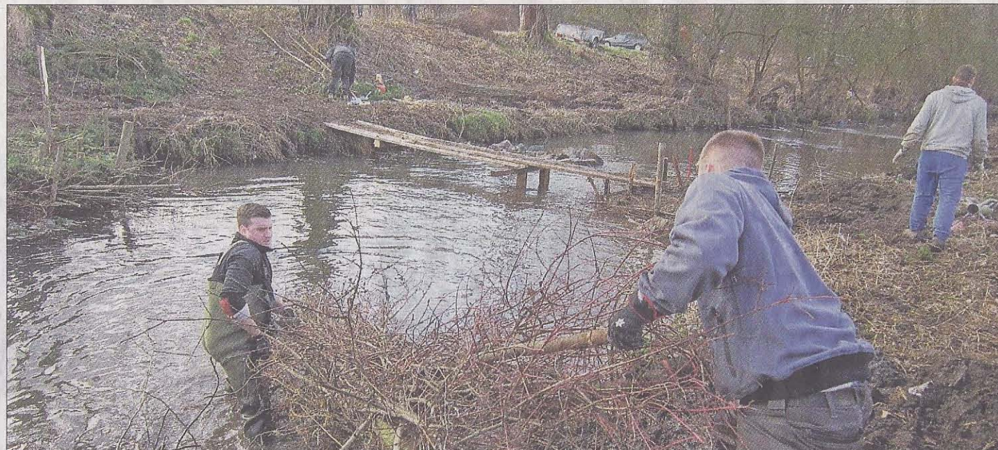
Die Schwippe-Angler beim Einbau einer Faschine in den Uferbereich des Gewässers
